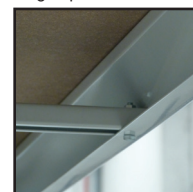
Fixation de la traverse de renfort
